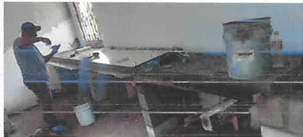
COLOCACION DE AZULEJO Y REPELLO EN CUCINA
