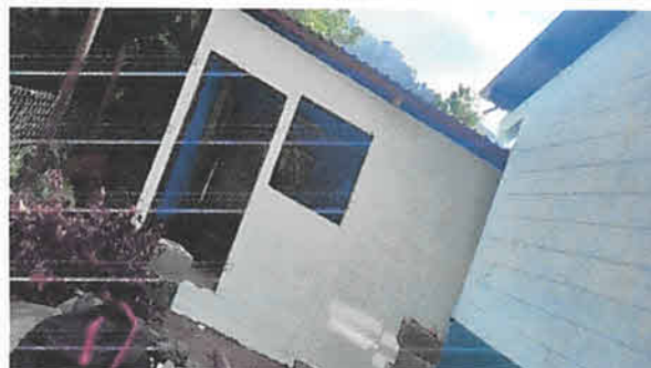
REPELLO EN AULA Y LAMINA TROQUELADA INSTALADA
