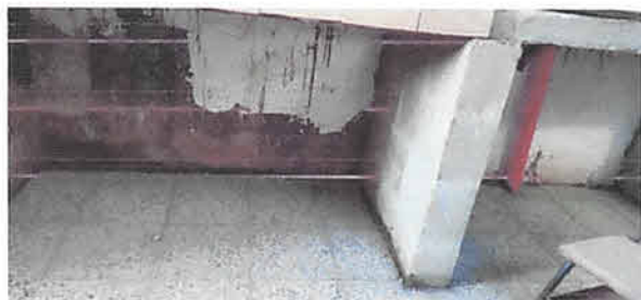
INSTALACION DE PISO DE GRANITO EN CUCINA, REPELLADO TERMINADO
