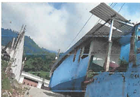
COLOCACION DE ESTRUCTURA METALICA Y LAMINA EN GALERA Y CUCINA 79 METROS LINEALES
